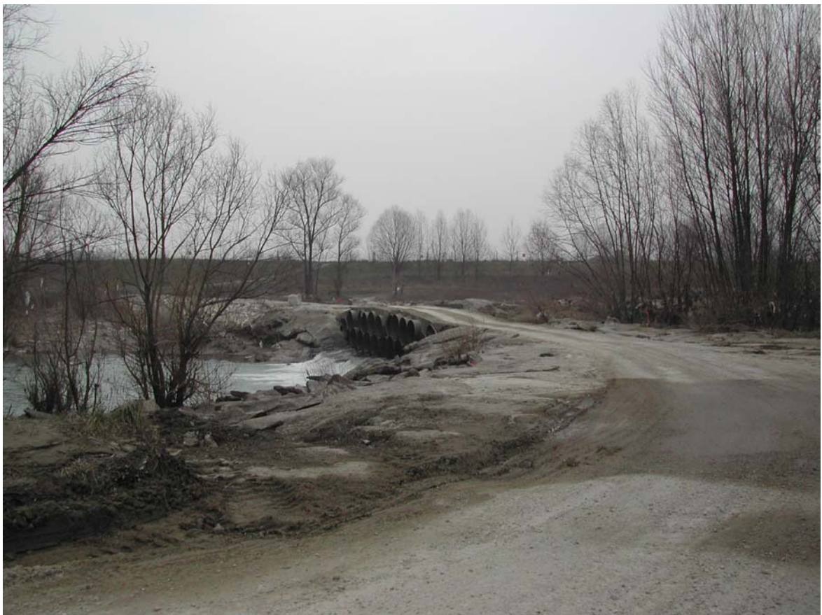
GUADO ESISTENTE PRESSO LE CAVE NORD AL TREBBO DI RENO (punto critico M)
