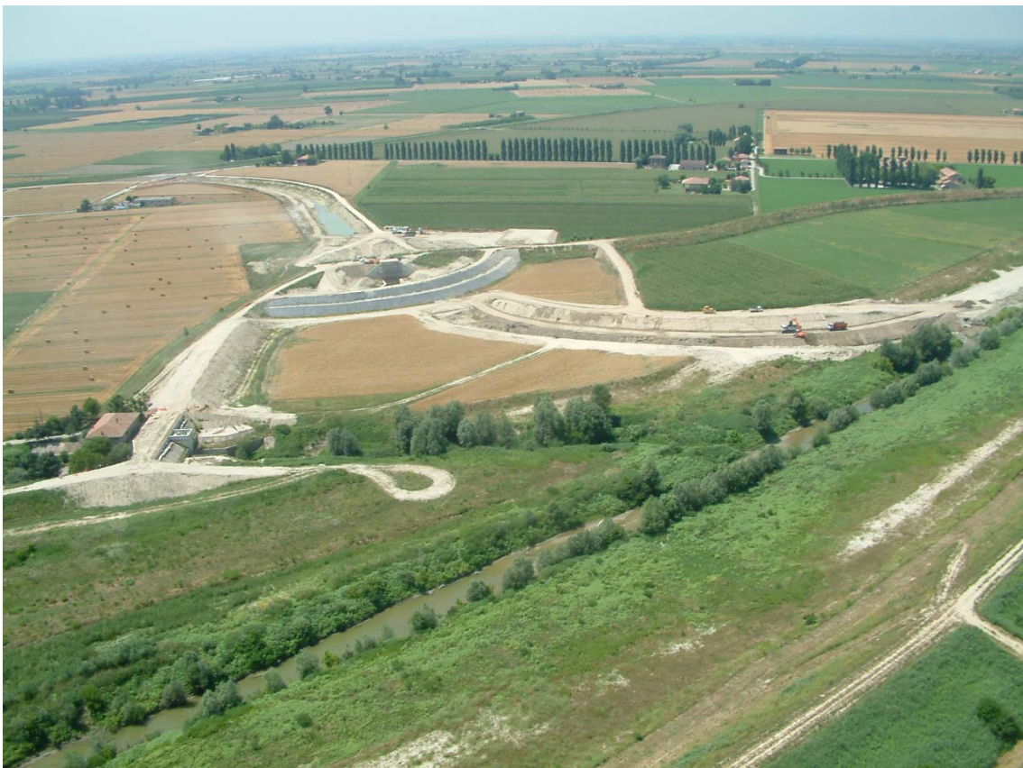
NUOVO CANALE IN COSTRUZIONE (punto critico R)
