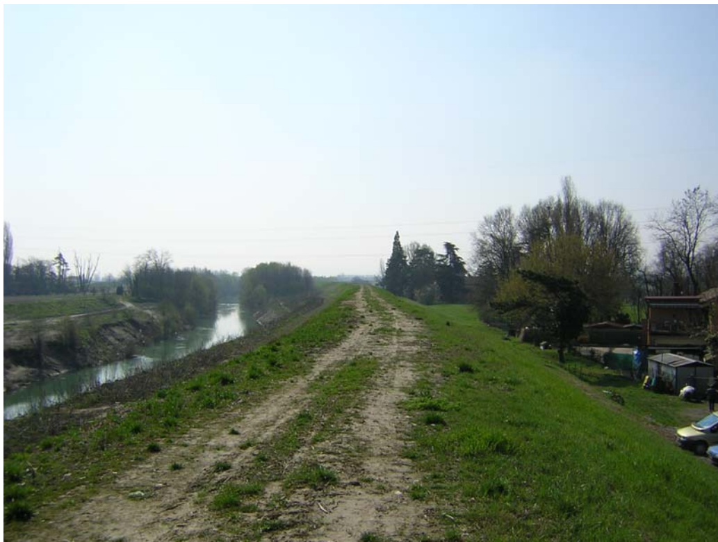
ARGINE DEL RENO PRESSO BUONCONVENTO (COMUNE DI SALA BOLOGNESE)
