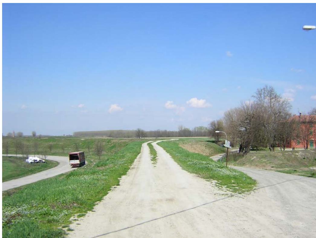
ARGINE DEL RENO PRESSO CASA LARGAIOLLI (COMUNE DI SALA BOLOGNESE)
