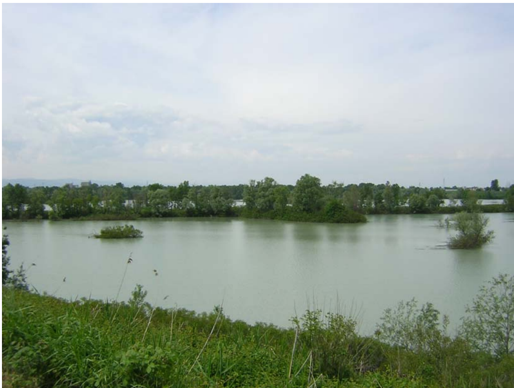
CASSE DI ESPANSIONE DEL FIUME SECCHIA
